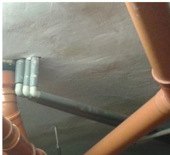
obr. /34/ Ležaté vodovodní potrubí v suterénu vedené v plastových trubkách
