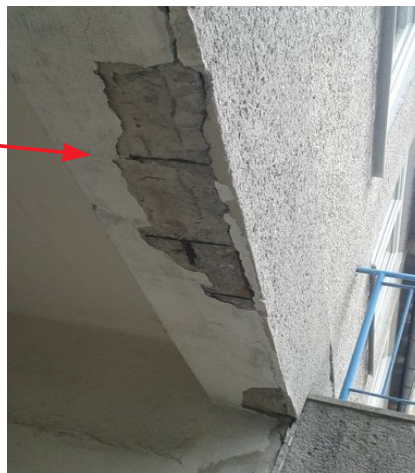
obr. /15/ Opadávání krycí vrstvy výztuže ŽB průvlaku nad vstupem ze suterénu objektu C na severovýchodní straně objektu
