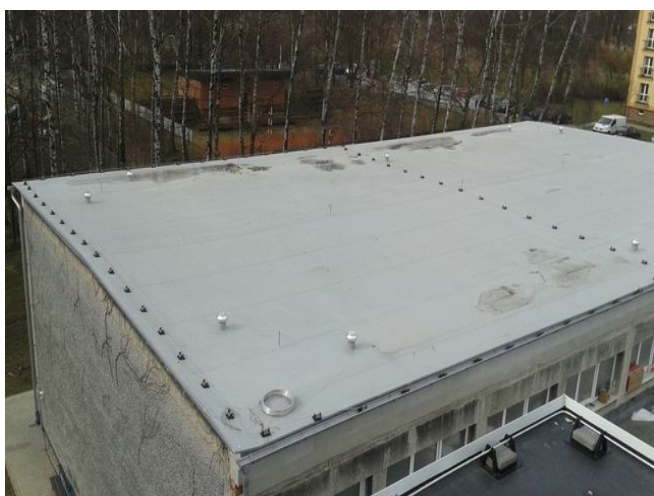
obr. /25/ Pohled na výskyt kaluží na střeše objektu tělocvičny
