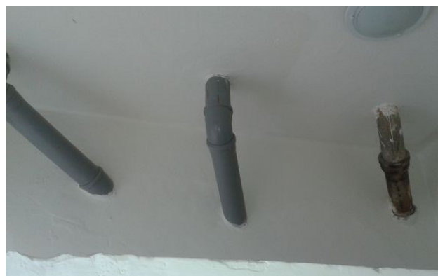
obr. /30/ Svislé odpadní potrubí je částečně po rekonstrukci vedeno v plastových trubkách
