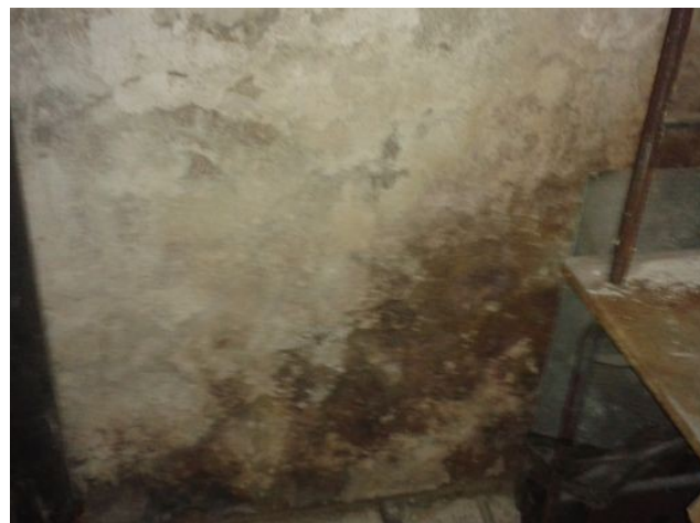
obr. /5/ Na stěnách suterénu spojovacího traktu se nacházejí vlhké mapy
