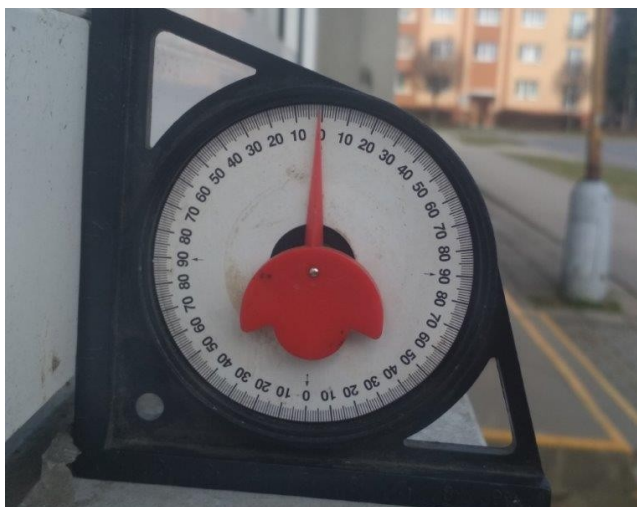
obr. /27/ Spád oplechování parapetů je místy nedostatečný (1°)
