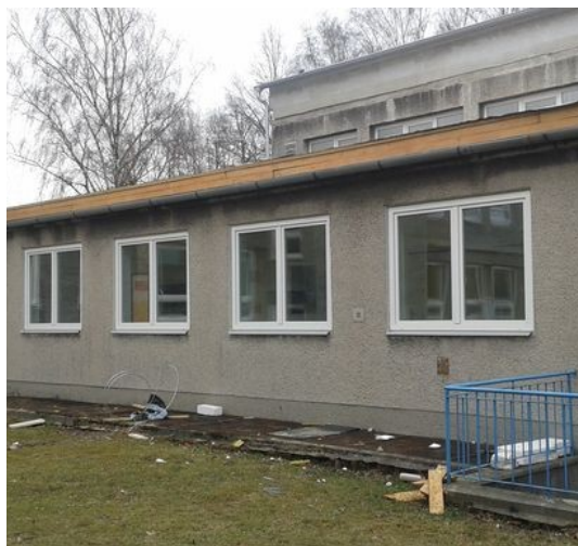
obr. /17/ Dvoukřídlové plastové okenní výplně s izolačními dvojskly (pohled ze dvora objektu)
