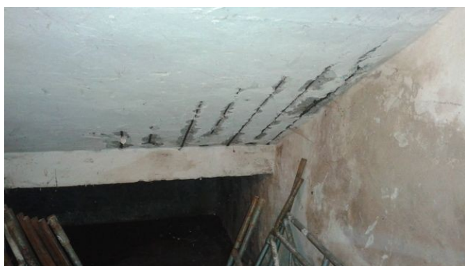
obr. /10/ Ocelová výztuž nejnižšího schodišťového ramene není chráněna ochrannou vrstvou a dochází k jejich degradaci
