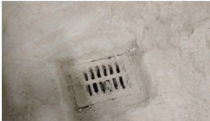
obr. /21/ Nášlapná vrstva suterénu je tvořená betonovou mazaninou
