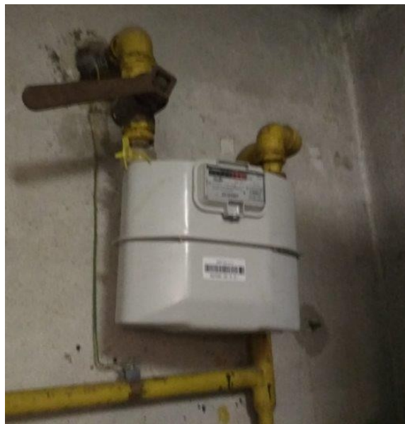
obr. /38/ Plynoměrná sestava
