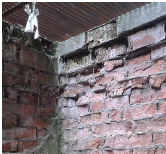
obr. /19/ Ochranné stěny anglických dvorků jsou na hranici svojí životnosti
