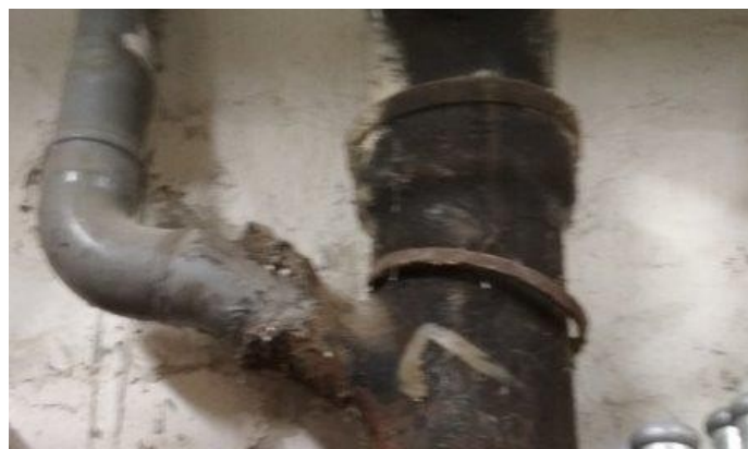
obr. /32/ Provizorní napojení plastového odpadu na původní litinové odpadní potrubí
