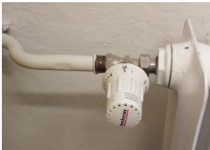
obr. /42/ Otopná tělesa jsou doplněna termostatickými hlavicemi
