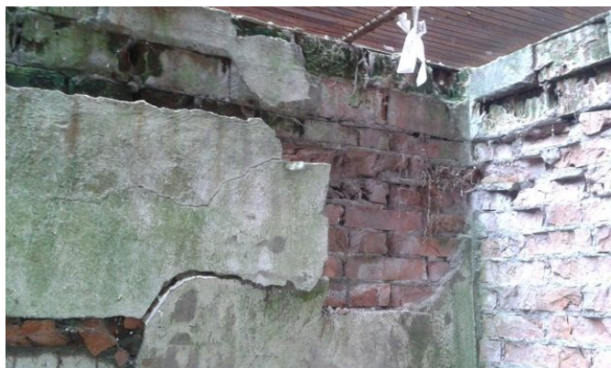
obr. /8/ Destrukce omítky a zdiva anglických dvorků
