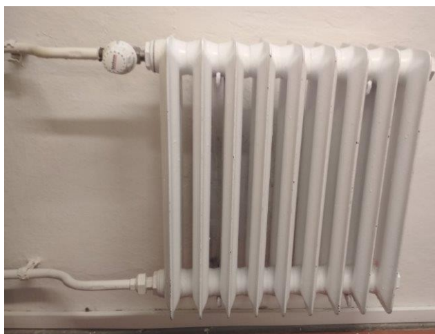
obr. /41/ Původní litinový článkový radiátor
