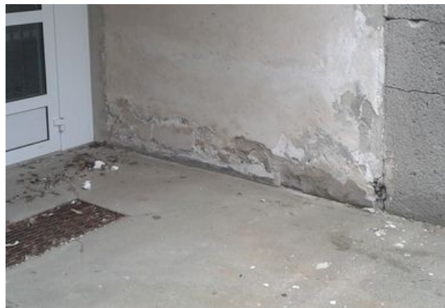
obr. /7/ V místě vstupu do suterénu objektu C je zdivo nadměrně hydrofyzikálně namáháno a opadává z něj omítka
