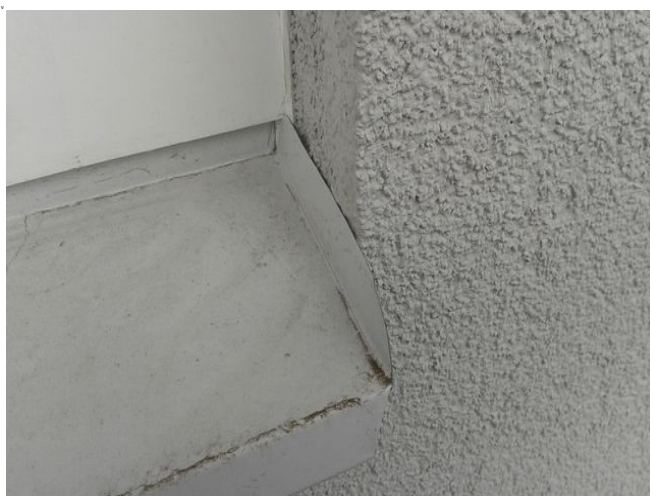
obr. /26/ Netěsné napojení parapetu na ostění okna výtahové šachty – objekt A
