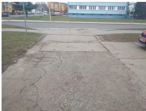
obr. /23/ Příjezdová cesta k jídelně je nadměrně zdeformovaná
