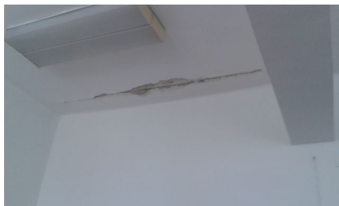
obr. /13/ Trhlina ve stropní konstrukci, která se pravděpodobně nachází v místě styku stropních panelů
