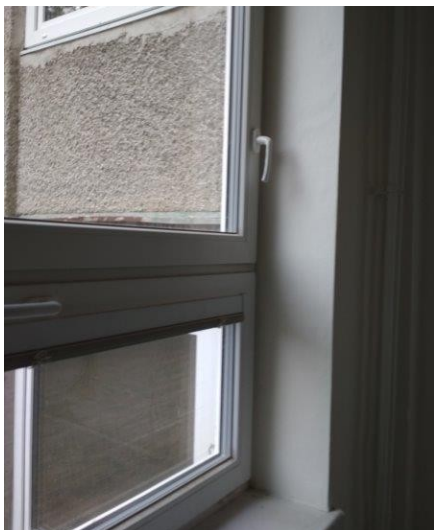
obr. /18/ Ze strany interiéru jsou okenní výplně doplněny plastovým parapetem
