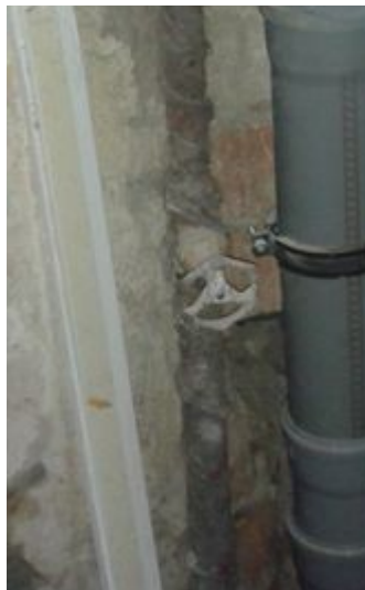
obr. /33/ Původní odpadní potrubí vedené v ocelových trubkách
