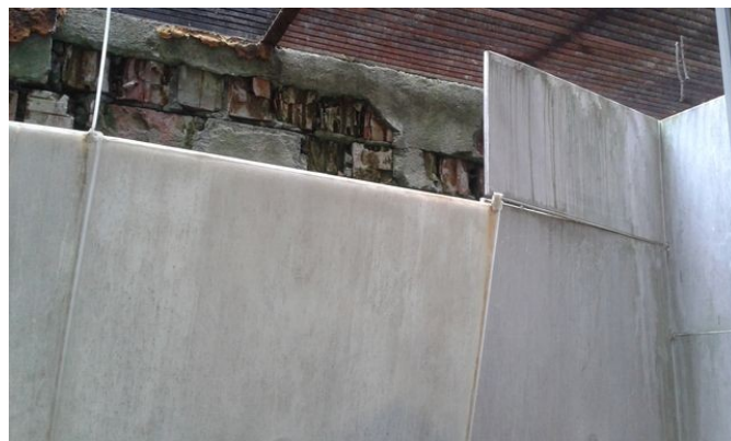
obr. /9/ Destrukce omítky, zdiva a plastových desek anglických dvorků
