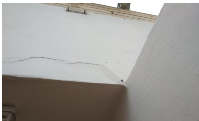
obr. /12/ Vodorovná trhlina v místě střešního světlíku – objekt C
