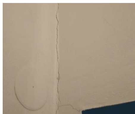
obr. /11/ Trhlina v nároží svislých stěn (tělocvična)
