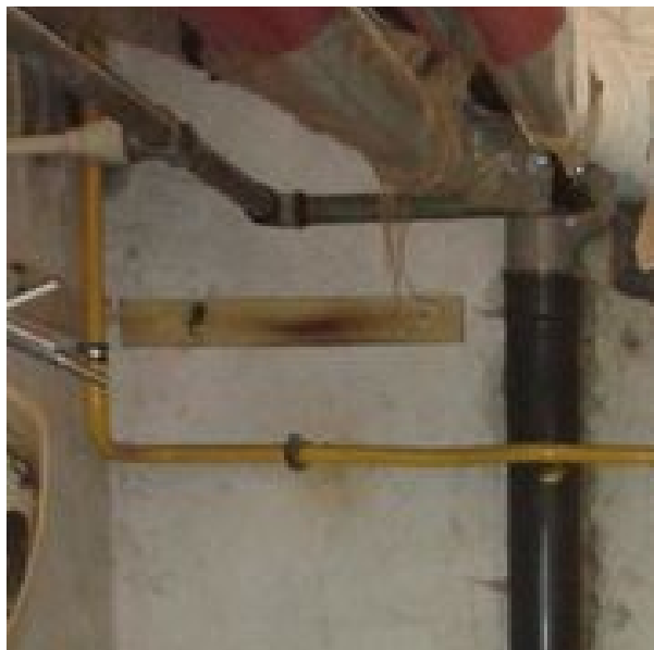
obr. /37/ Rozvody plynovodu jsou opatřeny nátěrem žluté barvy
