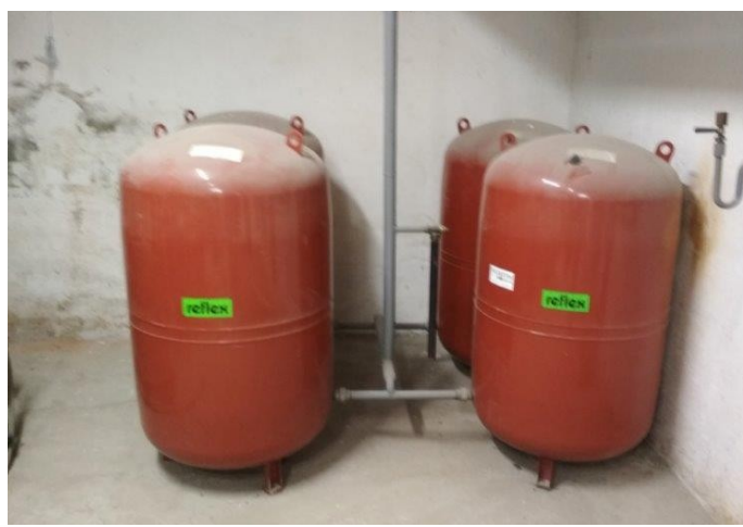
obr. /44/ Červené membránové expanzní nádoby
