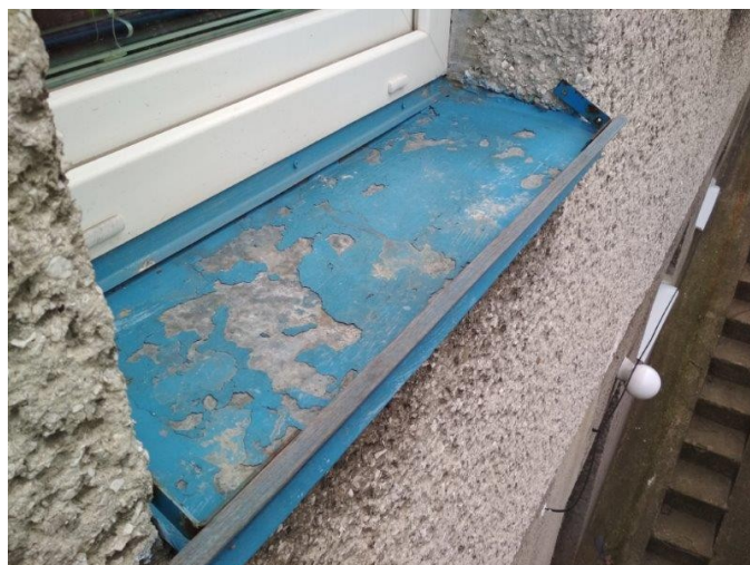
obr. /28/ Ochranný nátěr původních parapetů je zdegradovaný
