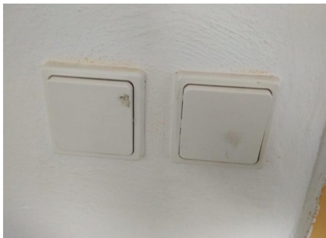
obr. /39/ Zánovní vypínače vnitřního osvětlení
