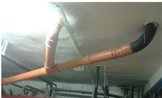
obr. /29/ Pohled na napojení původního litinového odpadního potrubí na nové odpadní potrubí z KG trub
