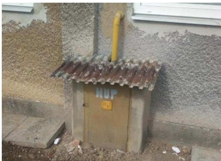
obr. /46/ Ochranná stříška hlavního uzávěru plynu je zdegradovaná a doporučujeme její rekonstrukci
