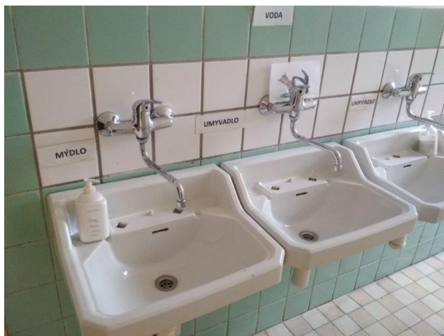
obr. /35/ Nástěnná páková výtoková armatura
